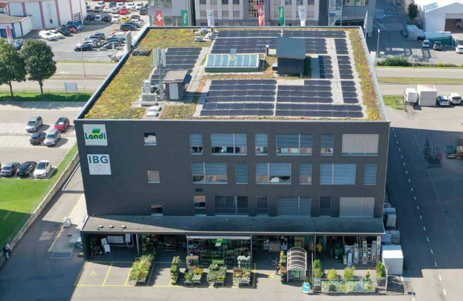
Die ca. 100-kWp-Anlage bei der LANDI Oberbüren wurde 2020 fertiggestellt und in Betrieb genommen.
