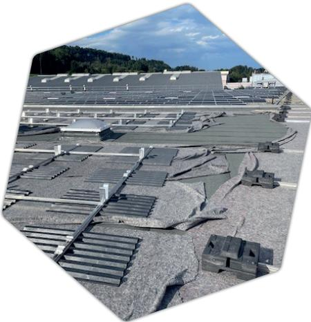
Ergänzt wird dieses Engagement durch die Errichtung einer neuen PV-Anlage im Neubau «Baumgarten» in St. Margrethen. Mit einer Leistung von 133 kWp, bestehend aus 330 Modulen à 400 W, generiert diese Anlage einen Jahresertrag von ca. 130'000 kWh, der nahezu 60 Haushaltungen entspricht. Der erzielte Eigenverbrauch von 85% – aufgeteilt zwischen dem LAVEBA Shop, der Tankstelle, dem Gewerbebereich sowie 43 Wohneinheiten – demonstriert, dass auch hier die
